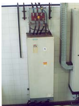
Figura 12 – Inversor de frequência para acionamento do motor da bomba de recalque
