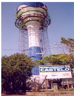
Figura 14 – Fase de execução da pintura externa do reservatório.
