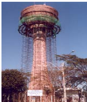
Figura 13 – Início do trabalho recuperação e impermeabilização do reservatório.
