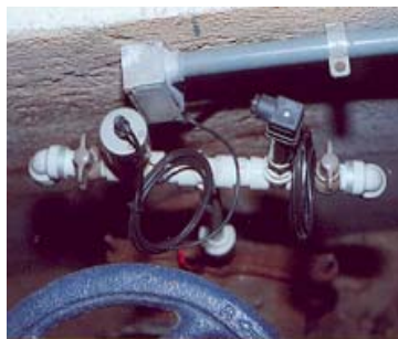
Figura 10 – Sensor de pressão instalado na saída do reservatório.
