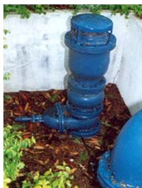
Figura 9 – Válvula tipo “anti-slam” instalada junto ao “by-pass” do reservatório.
