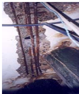
Figura 8 – Deterioração da estrutura interna do reservatório.
